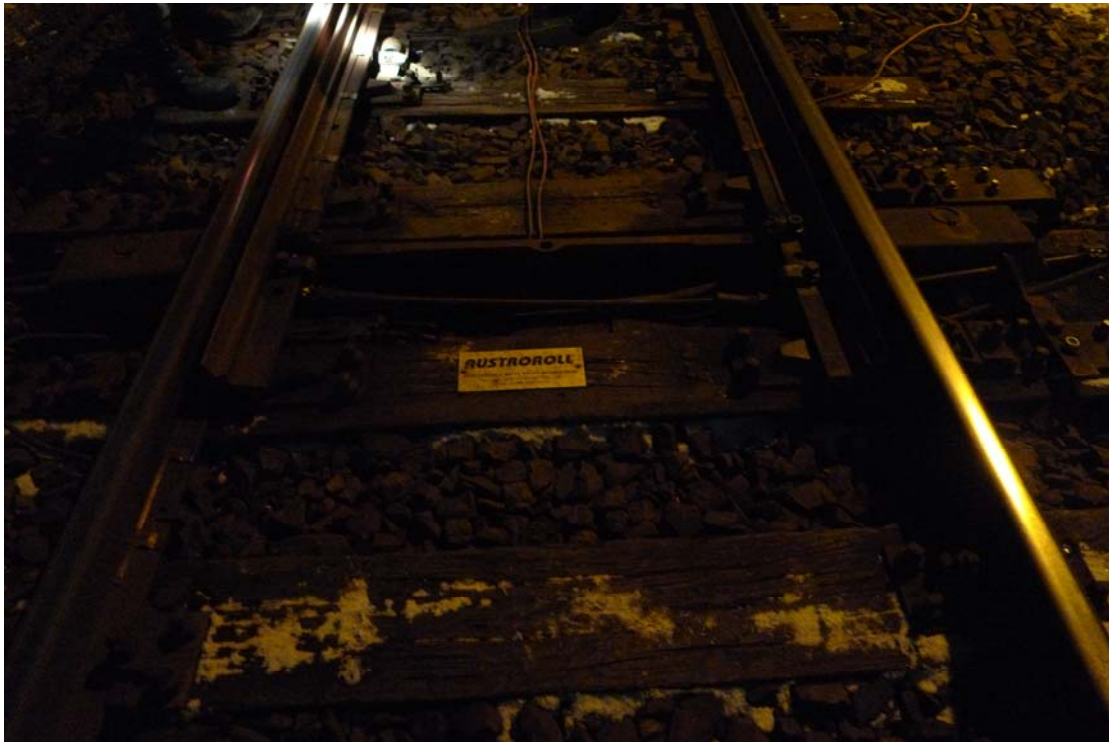
Bild 3: aufgefahrene Weiche 1, Üst Hordorf
